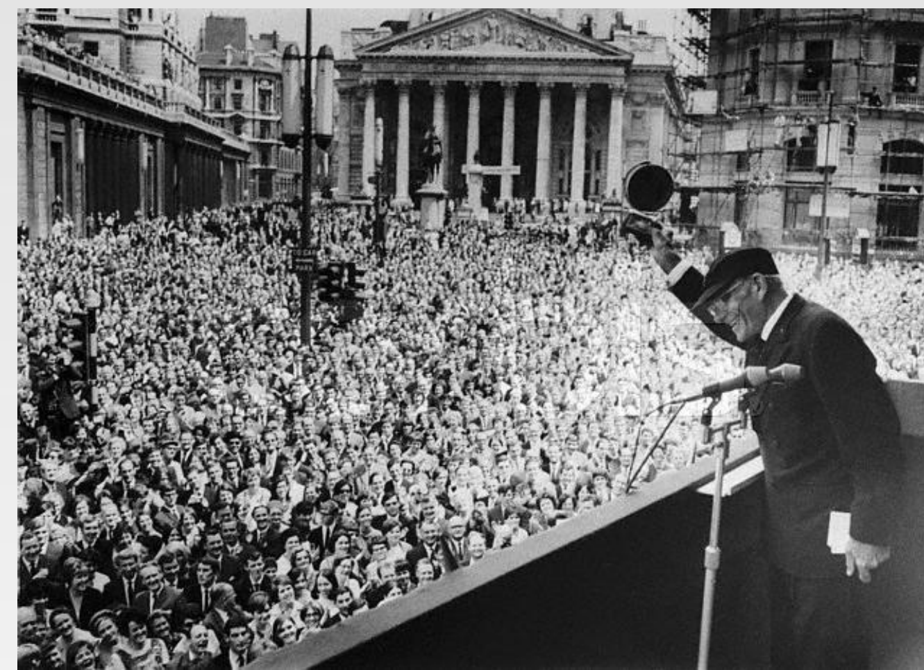
A Mansion House a l'arribada de la volta al món
