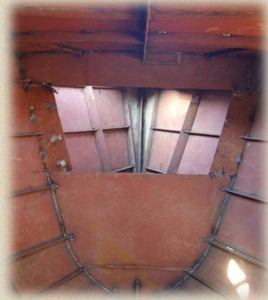
Interior de la caja de cadena (Soutullo, s.f.).
