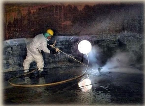
Limpieza del interior de un tanque de carga (Supportservice, s.f.)
